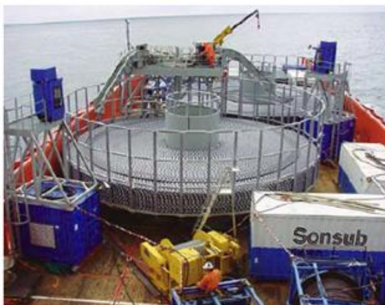
Abbildung 11-14: Die Verlegung des VSC-HGÜ VPE-Land-Kabels
