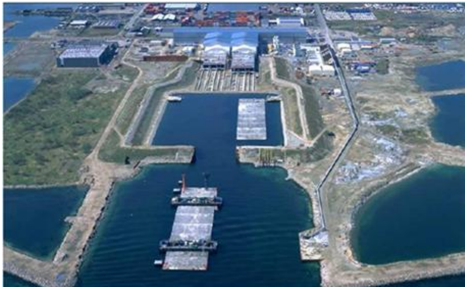
Abbildung 11-29: Herstellung von Tunnelsegmenten im Trockendock
