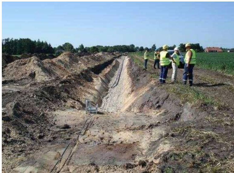
Abbildung 10-10: Verlegung eines VPE-HGÜ-Kabels
