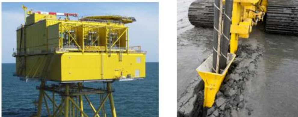
Abbildung 11-15: Offshore Plattform und die Verlegung des VSC-HGÜ VPE-Seekabels in Wattenmeer
